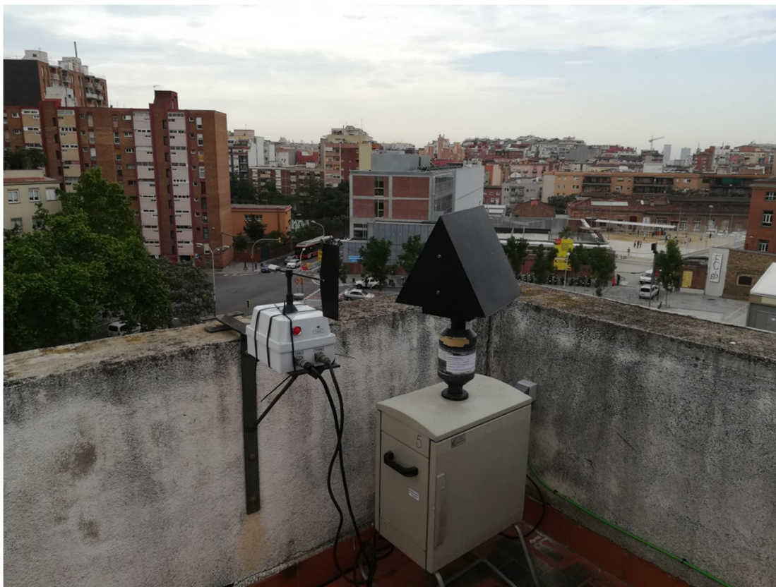
FIGURA 4. Equip instal·lat a l'edifici de la biblioteca Sant Andreu (Barcelona)
