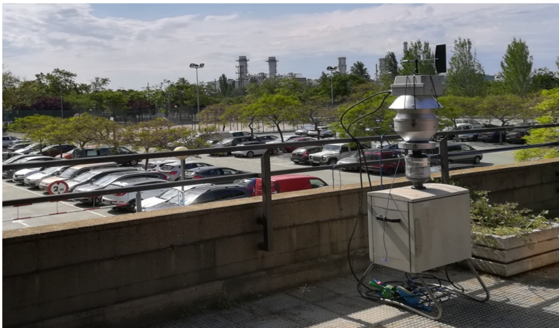
FIGURA 8. Equip instal·lat al sostre de l'edifici de l'escola d'ensenyament primari Catalunya (Sant Adrià del Besòs).
